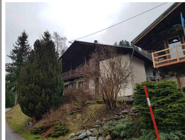
Photo façade Nord-ouest
