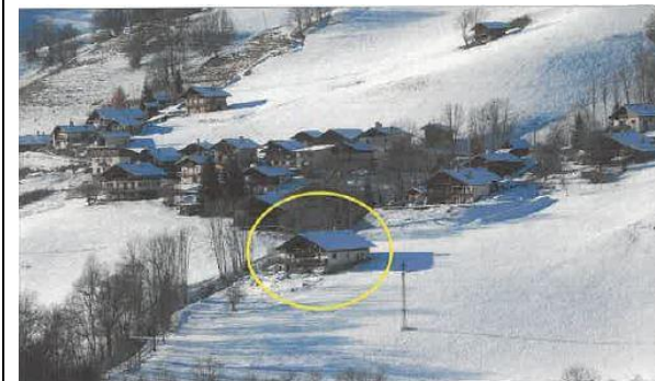
Photo vue d'ensemble du bâtiment
